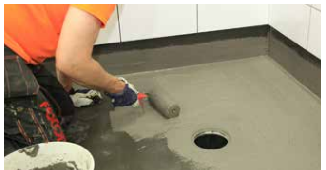
12. Levitä toinen kerros vedeneristettä kun ensimmäinen kerros on kuivunut. Laatoitus voidaan aloittaa aikaisintaan kun on kulunut 4 tuntia jälkimmäisestä käsittelystä. 2 kertaa levitettyinä tulee kuivapaksuuden olla kiviainespohjaisilla pinnoilla väh. 0,8 mm ja muilla pinnoilla 1 mm. Puhdista kädet ja työvälineet vedellä.
