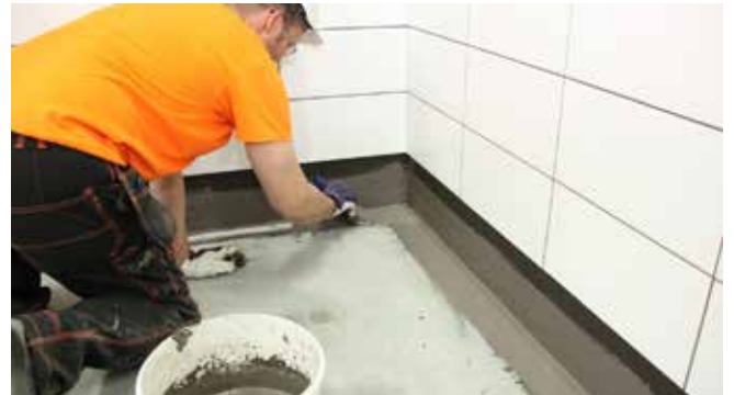
10. Käsittele aluksi lattian ja seinän rajakohdat ja asenna lattiakaivon vahvikekappale.
