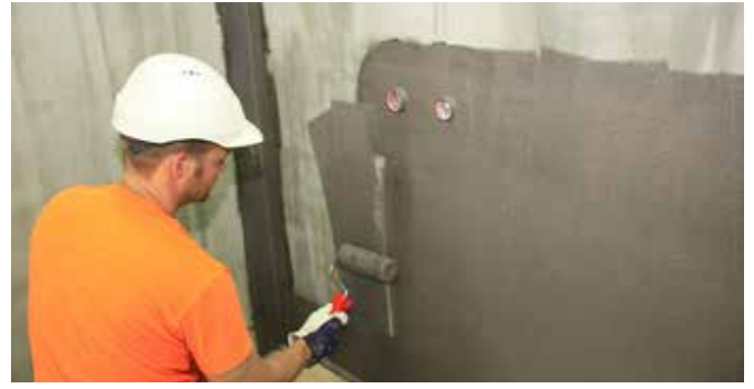
6. Levitä vedeneristettä koko eristettävälle alueelle.
