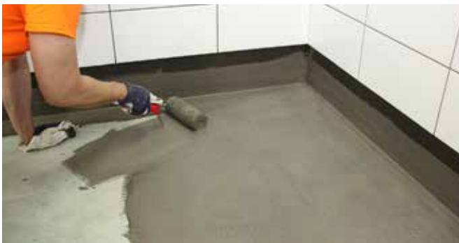
11. Kaivolaippa KL-B asennetaan painamalla se kiinni tuoreeseen eristeeseen. Sen jälkeen vedeneristä lattia kauttaaltaan.
