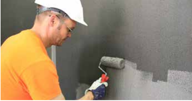
7. Ensimmäisen kerran käsittelyn jälkeen voidaan toinen käsittelykerta tehdä aikaisintaan 1,5 tunnin kuluttua. Pintojen tulee aina olla kuivia ennen kuin seuraavaa työvaihetta aloitetaan.
