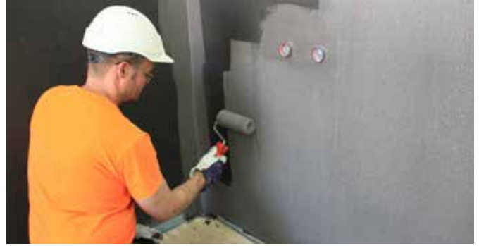
6. Levitä vedeneristettä koko eristettävälle alueelle.
