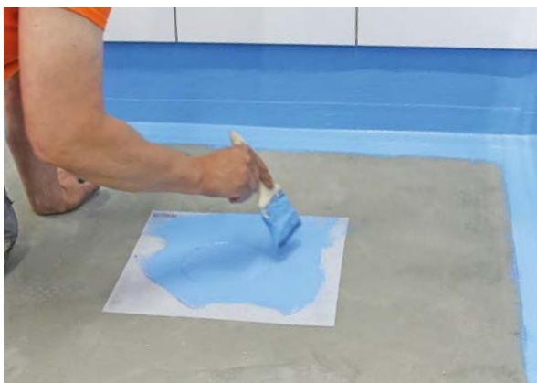
Levitä vedeneriste kauttaaltaan kaivolaipan päälle
