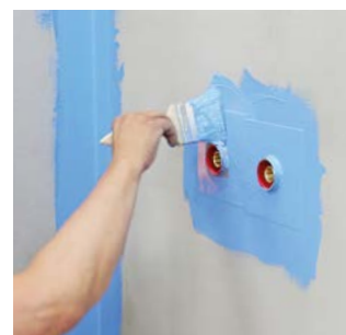
Vahvikkeiden tulee olla kahden vedeneristyskerroksen välissä
