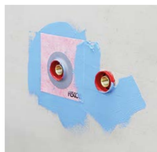
Vahvikkeiden tulee olla kahden vedeneristyskerroksen välissä
