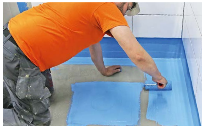
Levitä vedeneriste muulle lattiapinnalle
