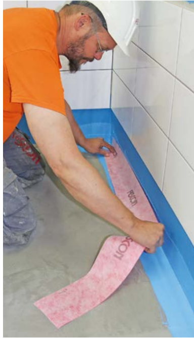
Vedeneristysnauhan asennus
