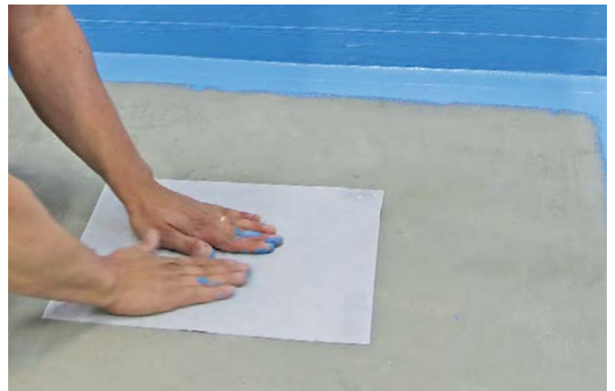
Kaivolaippa KL-B:n asennus
