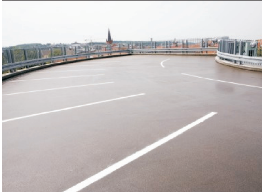
Akryylimassapinnoite toimii pysäköintitason vedeneristeenä.
