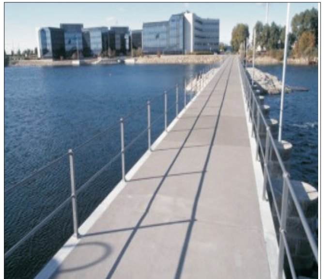
Sillan vedeneristyspinnoitus Nanten Matacryl-vedeneristemassalla
